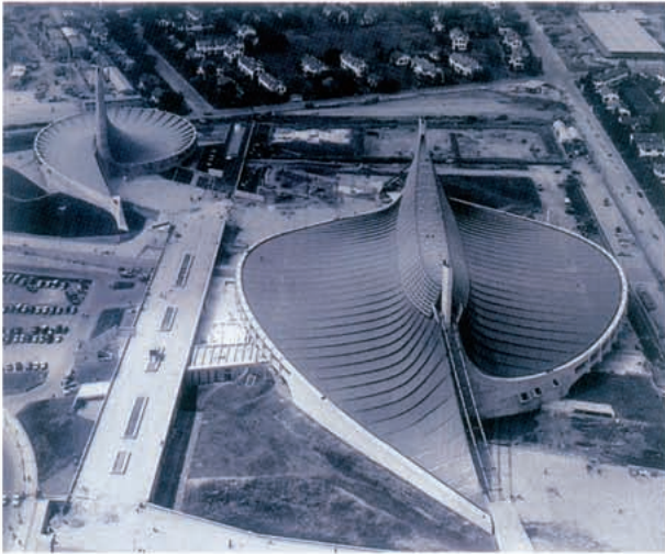
川口衛先生が構造設計を担当された国立屋内総合競技場
