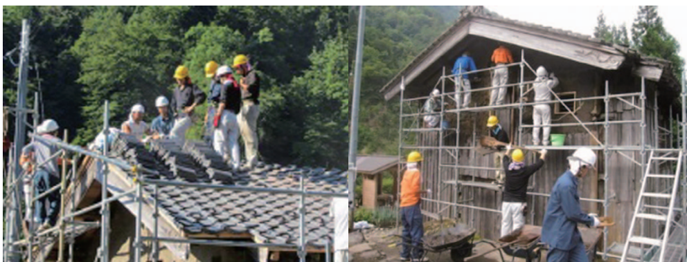
作業風景（左：瓦葺き替え、：外壁）
