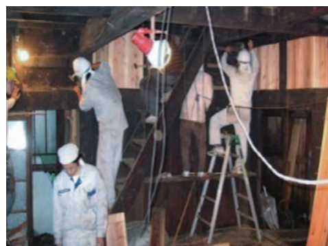
作業風景（内部）
