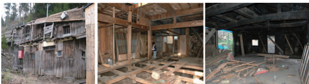
岩本豊家の改修
