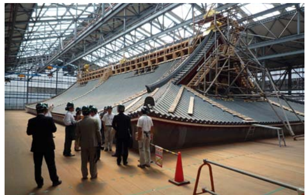
大極殿 復原工事
