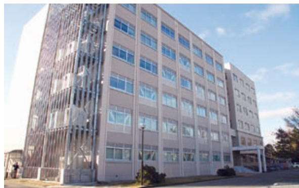
耐震改修後の情報・メディア工学棟
